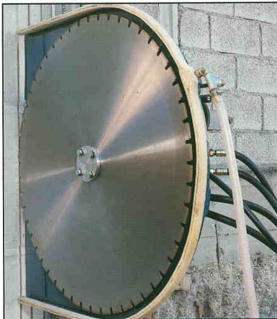
Taglio adiacente al muro con cuffia aperta lateralmente
