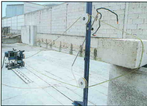
Taglio a filo a senso verticale mediante l'ausilio del telaio mobile con estremità regolabile per fissarla al soffitto e fissandola sul pavimento (in dotazione)
